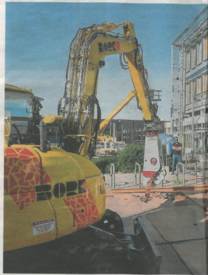
Demolition Day in het Alfa-college. André Weima
